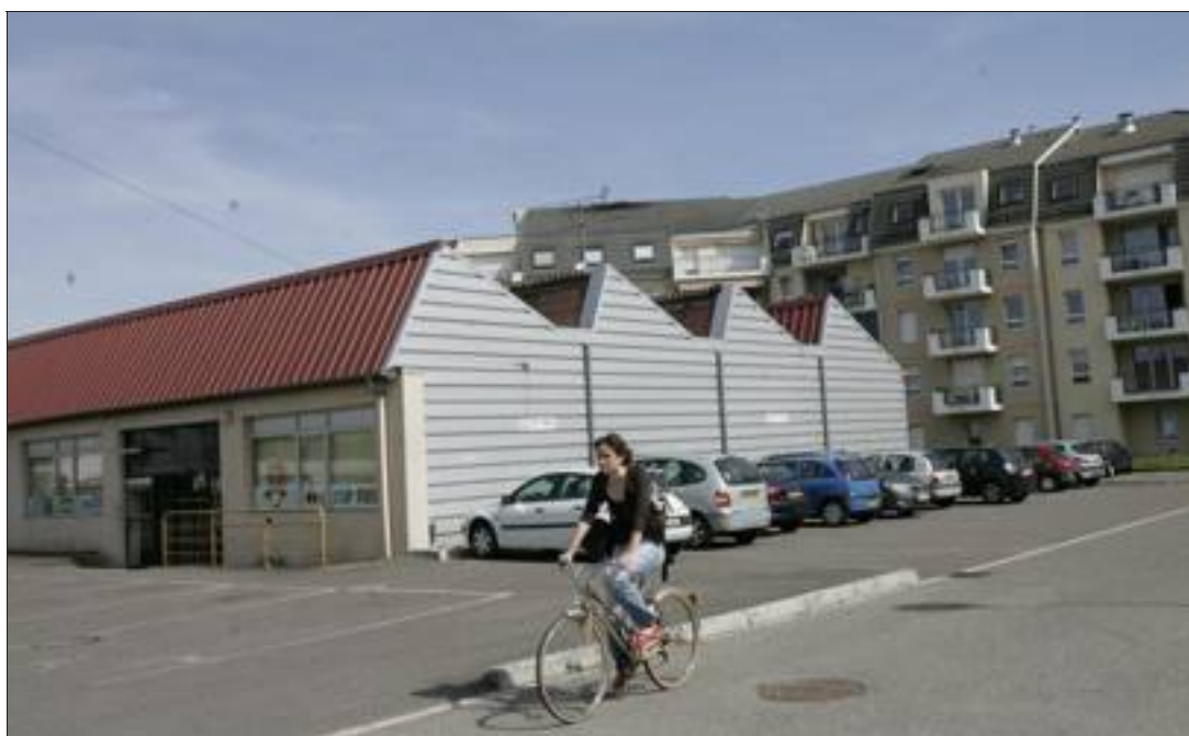
L'ancien local commercial de Stop Vidéo sera confié à l'association des Sheds qui projette d'y installer, entre autres, un restaurant-théâtre écologique et une brasserie bio. Photo Jean-Paul Domb
